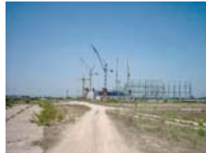
Belenen ensimmäisen yksikön rakennustyömaa. Kuvan lähde: www.belene-npp.com
