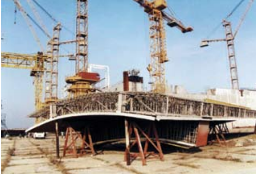
Suojarakennuksen seinäraudoituselementti miltei 20 vuoden takaa. Kuvan lähde: www.belene-npp.com
