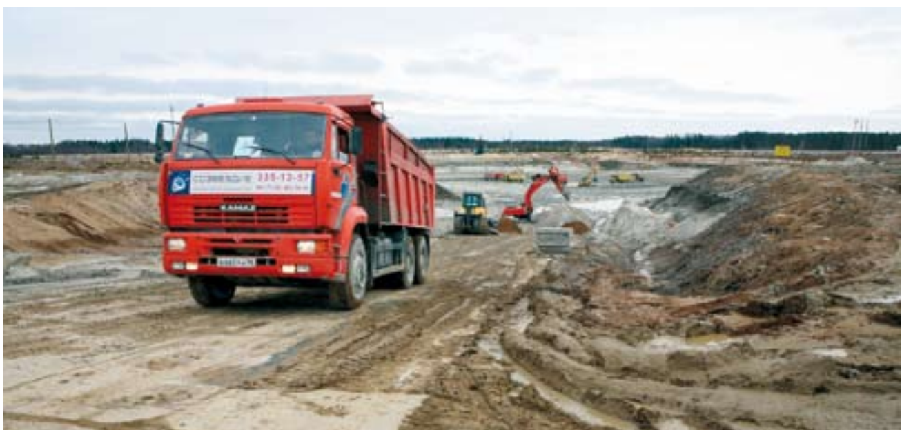
Maanrakennustyöt käynnissä LAES-2:n alueella Sosnovy Borissa.
