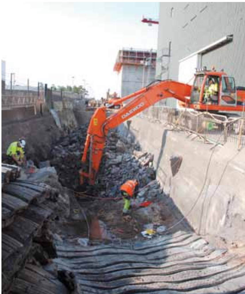
Inom projekt Plex genomförs åtgärder för att stärka byggnader mot jordbävningar och översvämningar. Foto: Urban Björk
