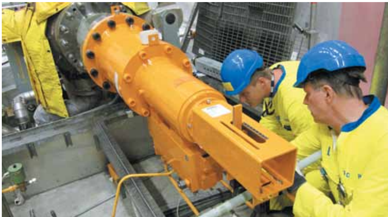
Nyinstallerade snabbstängningsservon undersöks. De aktiveras om turbinen behöver kopplas ur och högtrycksventilerna ska stängas snabbt. Foto: Patrik Tegelberg
