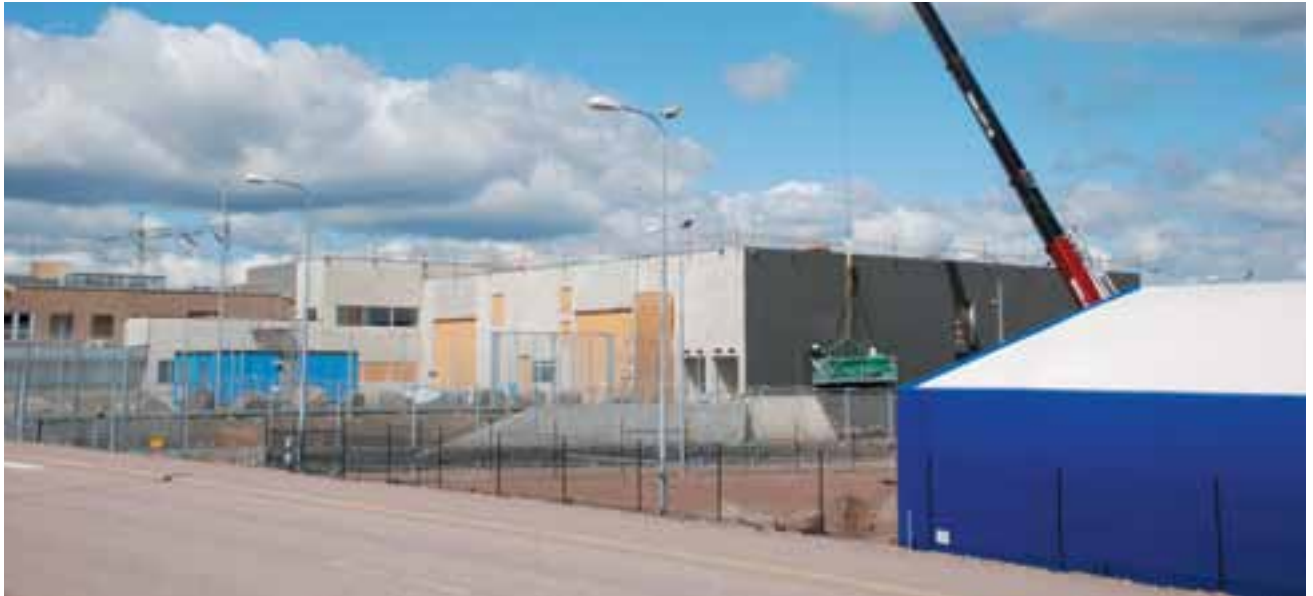
En ny inpasseringsbyggnad byggs på OKG. Foto: OKG, HK
