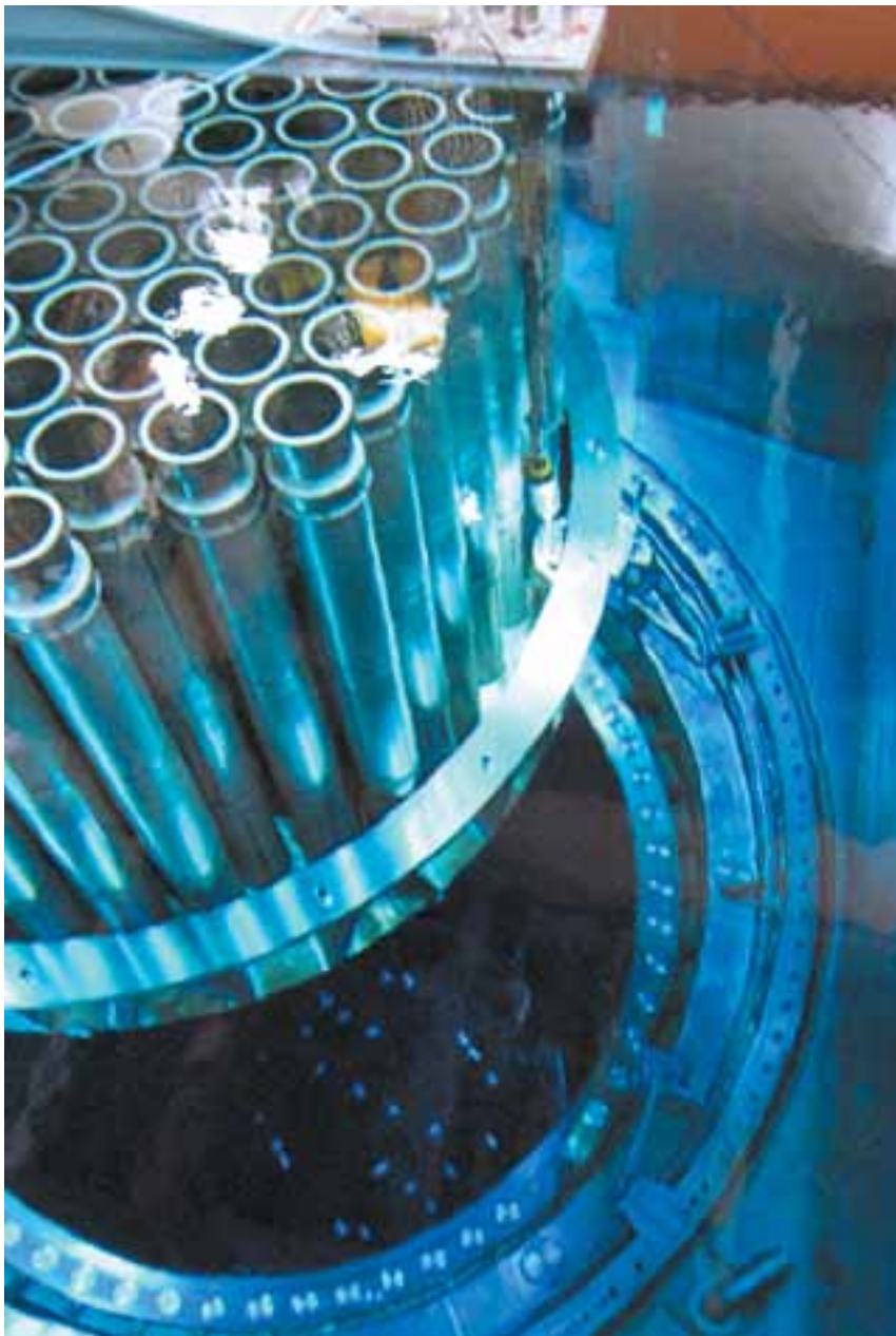
Reaktorns interndelar byttes under revisionen. Ny fuktavskiljare och nytt moderatortanklock installerades. Bilden visar ångseparatorerna på moderatortanklocket som sätts på plats i reaktorn. Foto: Nikolas Forsberg
