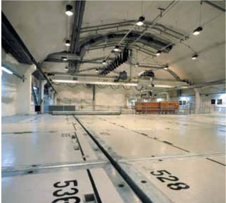
Näkymä Olkiluodon voimalaitosjätteen loppusijoitustilan (VLJ) MAJ-siiloon. (Kuva: TVO)
